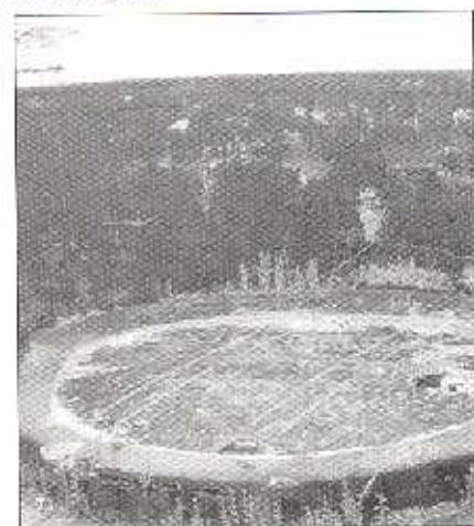
..... och här är nya pjäsplatsen i O II Fort Foto: Gustav Lundberg
