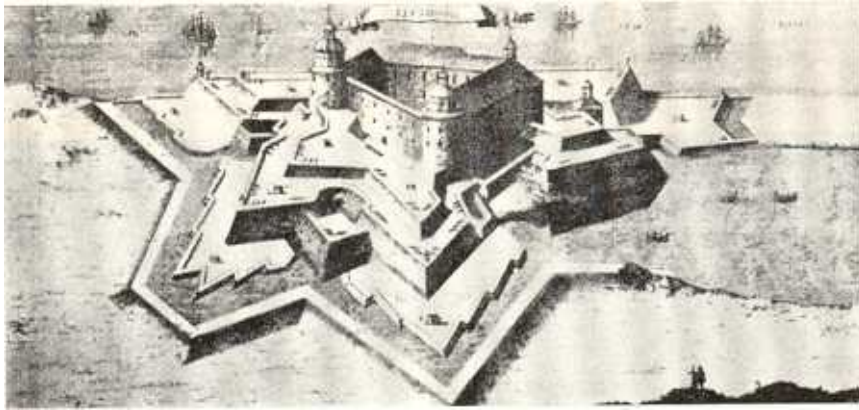
Gamla Älvsborgs fästning (Älvsborgs slott).
