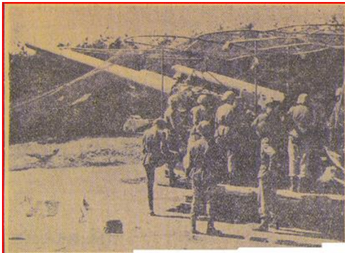
Vår största rörliga artilleripjäs, en 21. Centimeters kanon under sitt kamouflerande »fisknät» på batteriplatsen vid Åsa. Kanonen fraktas per bil i tre delar - enbart eldröret väger 10 ton - och kom med hjälp av en specialkonstruerad jättelastbil dras fram och lyftas ned i ställningen där monteringen i bästa fall är gjord på en timme. (Bilden godkänd för publicering) ..
