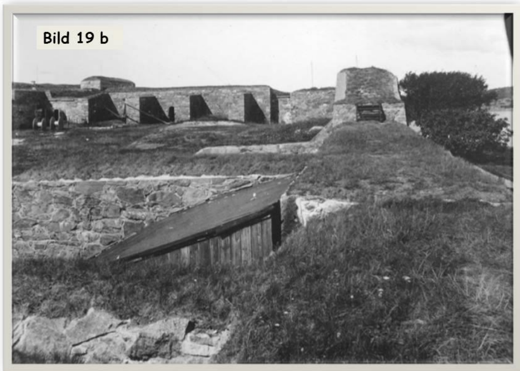
Östra flygelvallen b. Efter konservering
