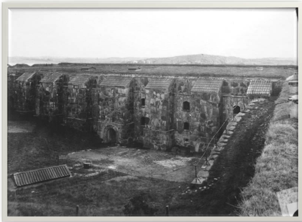
Kurtin 2. Strävpelare b. Efter tegelbeläggning
