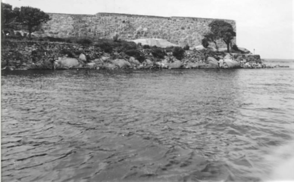
Östra flygelvallen reparerad
