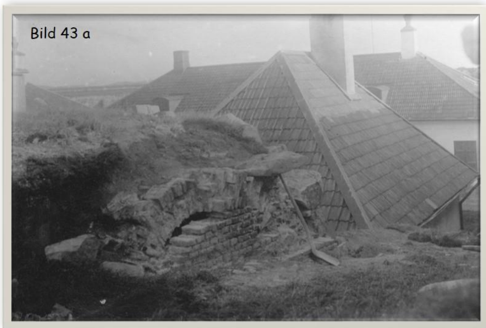
Avskuret valv tillhörande gång till krutkällare i Bastion Hummern Före konservering
