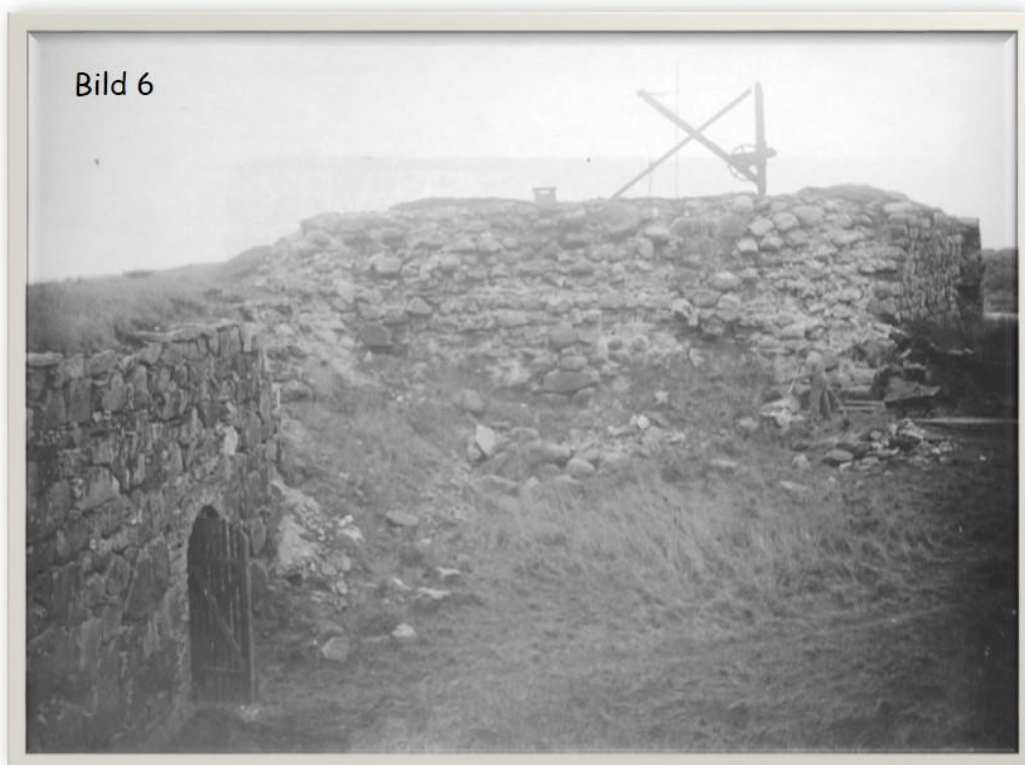
Västra hornets flank och del av kurtinen före arbetets början
