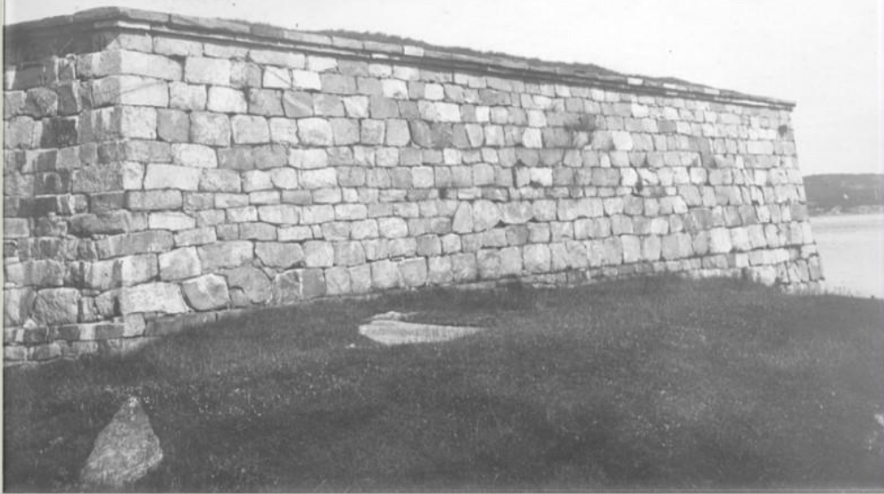
Östra fasaden före konservering
