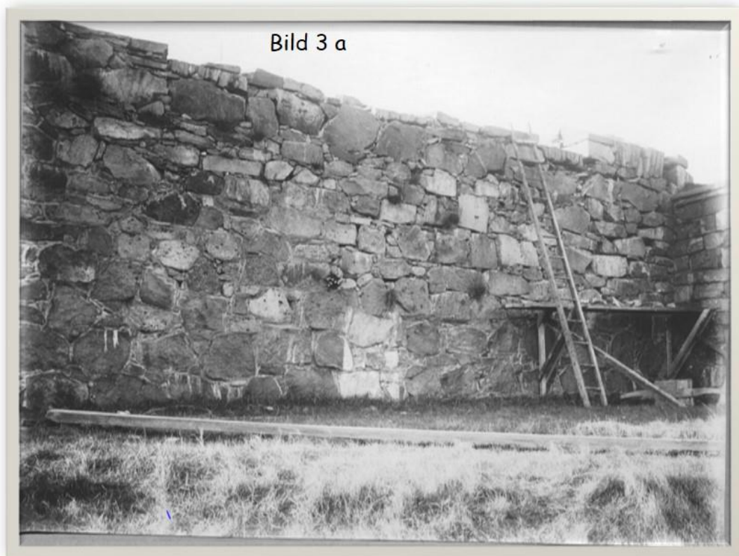
Norra delen av escarp till kurtin 1 före fogstrykning
