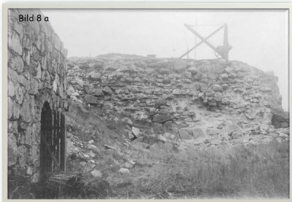
Västra hornets flank och del av kurtinen under framgrävande av skalmursgrunden
