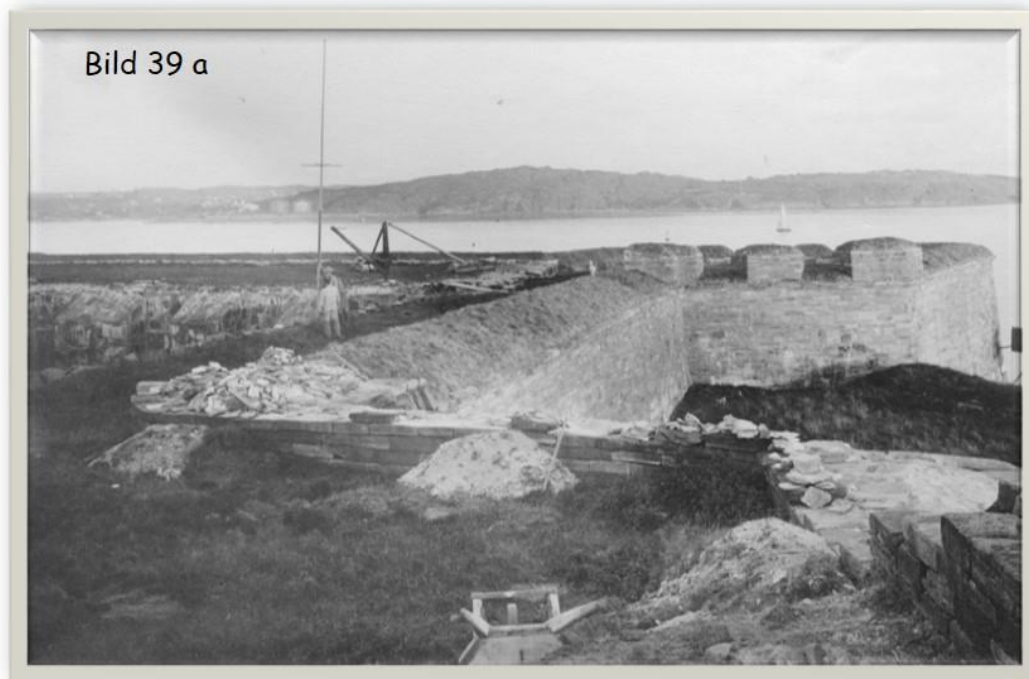
I förgrunden inre bröstvärnsslutning till Bastion Hvalfiskens under arbete. Där bakom bröstvärnskrönet till Kurtin 3 färdigt och Bastion Hafsfun
