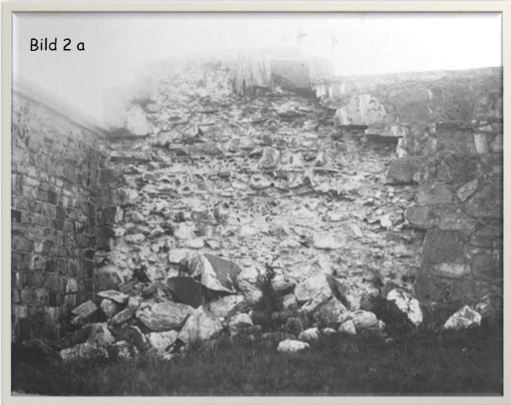
Bastion Delphin och escarp av Kurtin 1 med raserad skalmur före konservering
