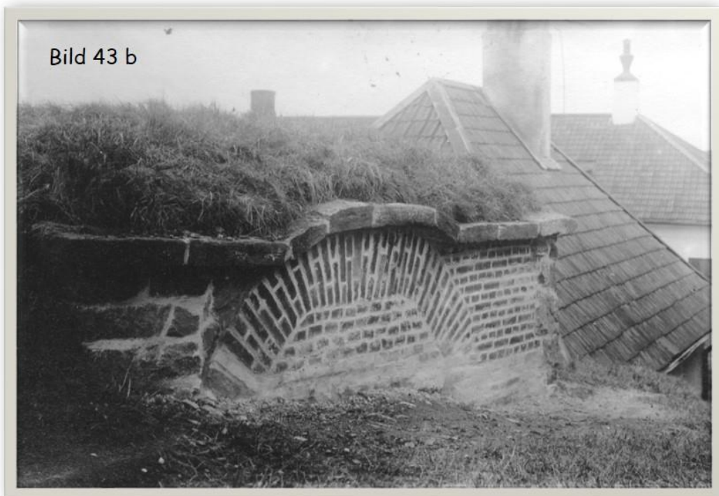
Avskuret valv tillhörande gång till krutkällare i Bastion Hummern Efter konservering
