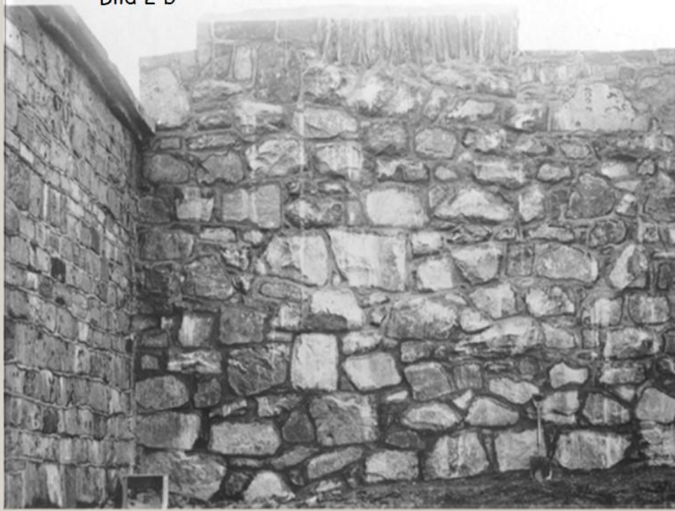
Bastion Delphin och escarp av Kurtin 1 med raserad skalmur efter konservering
