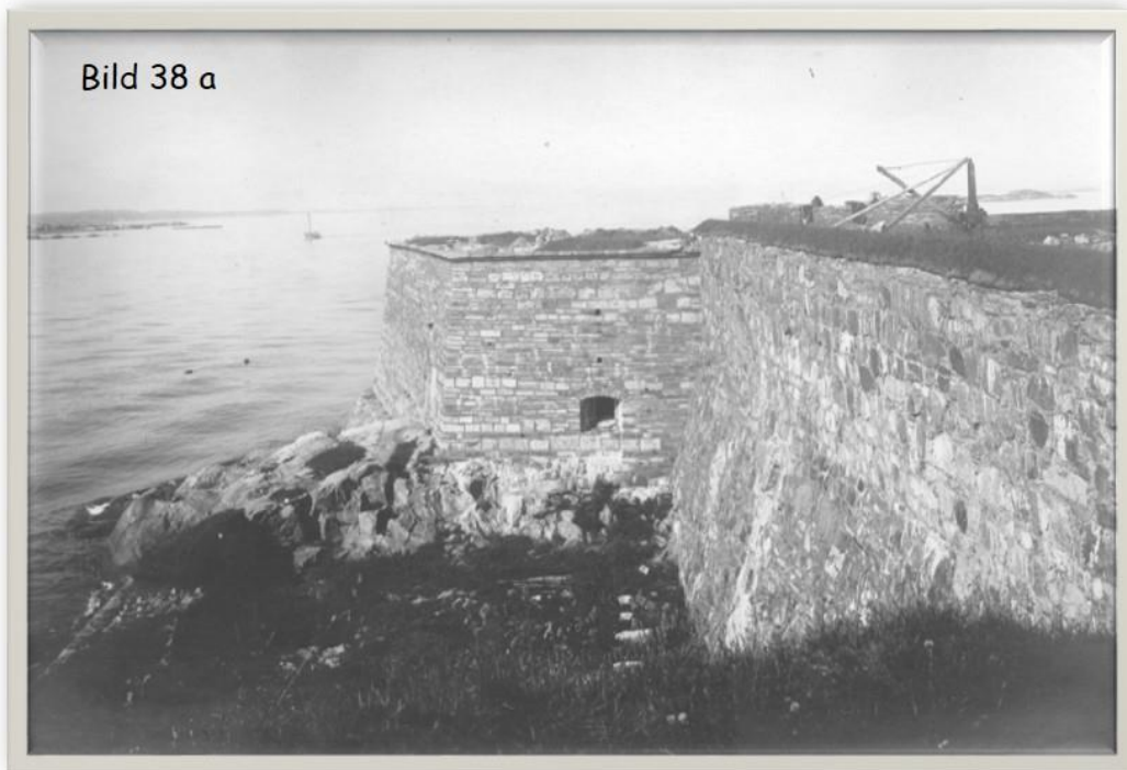
Bastion Hafstrunns östra flank före konservering
