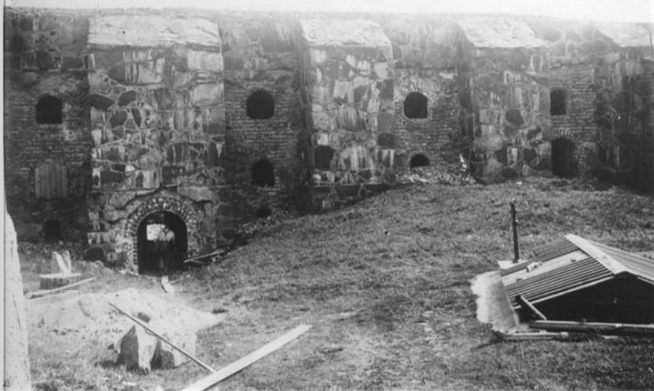
Kurtin 2 Inre del före konservering. Mellan strävpelarna tegel delvis Vittrat och nedfallet
