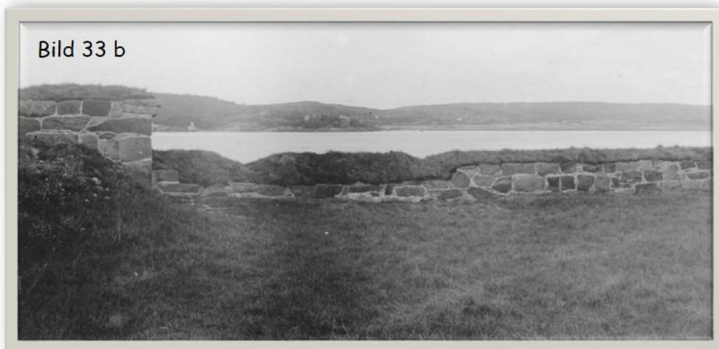
Bröstvärn till norra fasen av Bastion Nordstiernan Efter konservering
