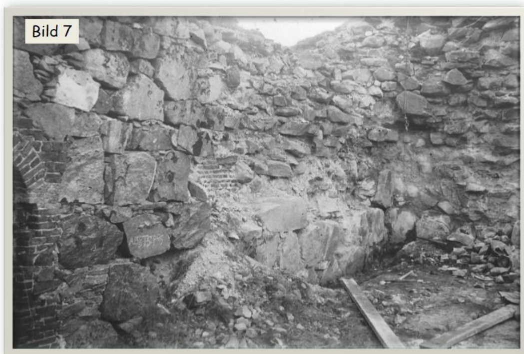
Vinkeln mellan västra hornets flank och kurtinen. Skalmursgrunden blottad
