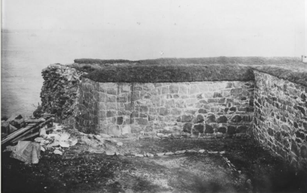
Del av kurtinen samt Östra Hornet, vars flank och stycke av fasen konserverats. Vid grävningen har en stensättning upptäckts som syns i förgrunden
