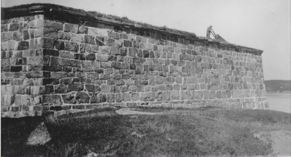
Östra fasaden efter konservering
