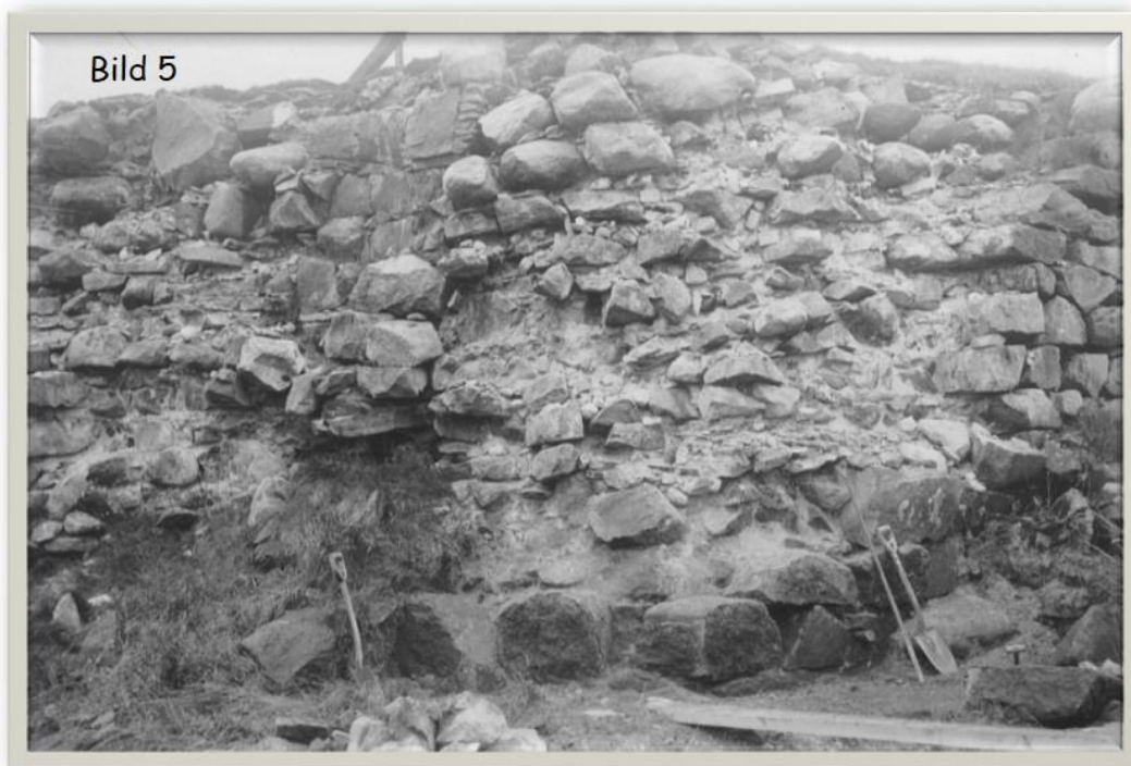
Hörnet mellan västra hornets flank och fas. Jord bortschaktad, grundstenar blottade.
