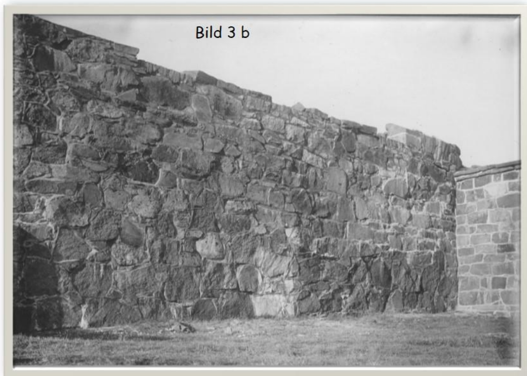
Norra delen av escarp till kurtin 1 efter fogstrykning
