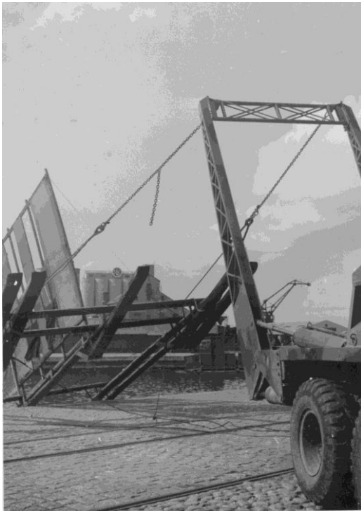
Sjösättning av sjömål i Ystad hamn. Brockway är mångsidigt användbar
