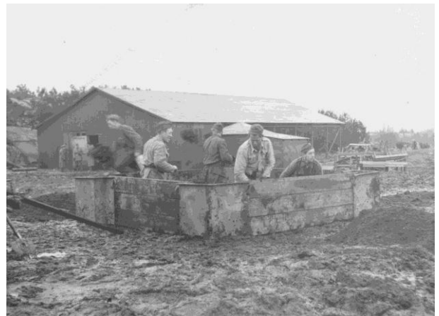
Bild 95. Byggande av pjäsgröp för 21 cm kan M/42
