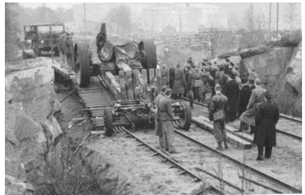
Bild 11/1 Lastning av 15 cm lavettfordon på järnväg med hjälp av lastbrygga, byggd av järnvägsmateriel.
