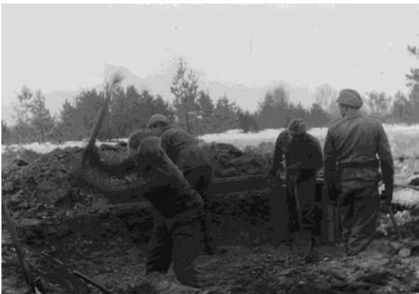
Bild 96a. Byggande av pjäsgrop för 21 cm kanon m/42. Skillingaryd ??
