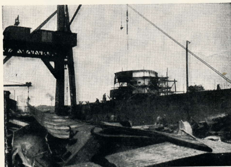
Minsveparna Sandön o. Ulvön under byggnad
